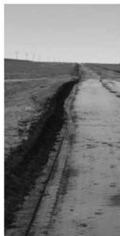
Control de Material Particulado
